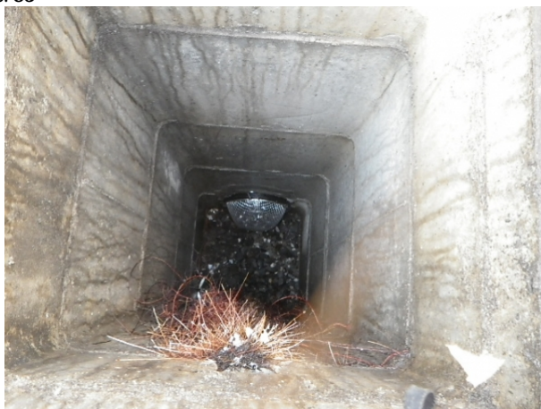
排水設備 > 最終枡（敷地内）
