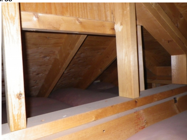
小屋裏＞梁、小屋組および野地板等
