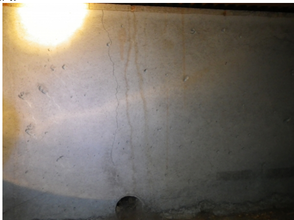
基礎および床下面 > 基礎 > 基礎立上り
