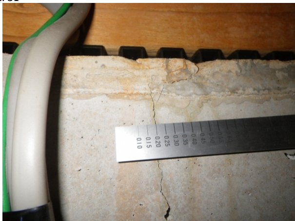
基礎および床下面 > 基礎 > 基礎立上り
