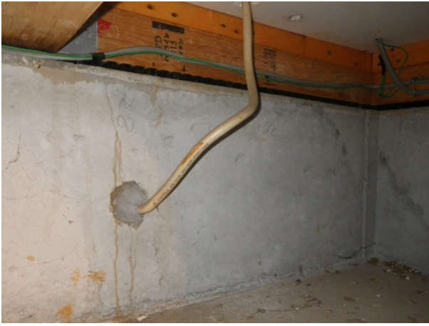
基礎および床下面 > 基礎 > 基礎立上り
