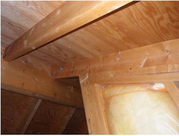
小屋裏＞梁、小屋組および野地板等
