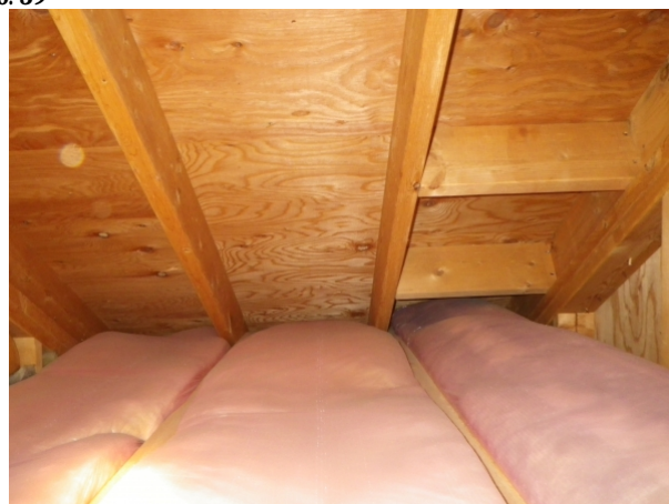
小屋裏＞梁、小屋組および野地板等
