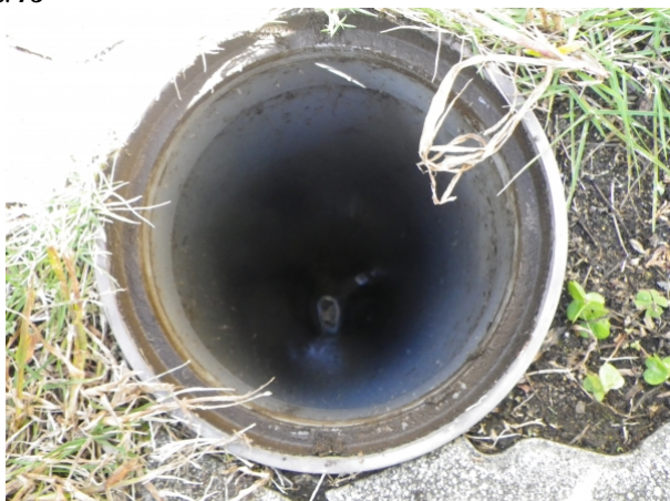
排水設備 > 最終拵（敷地内）
