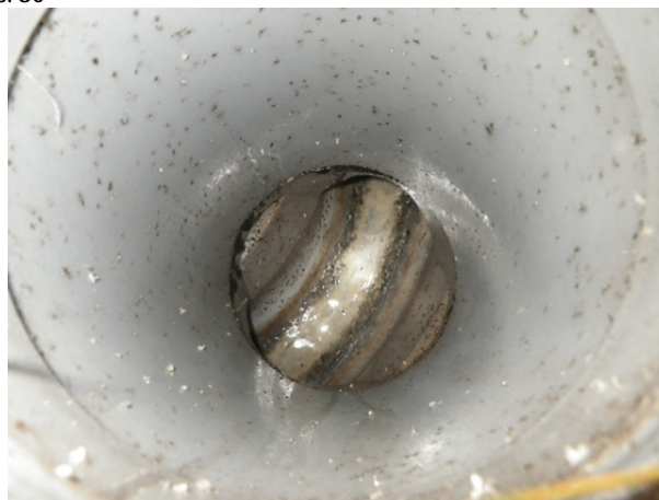
排水設備 > 最終枡（敷地内）
