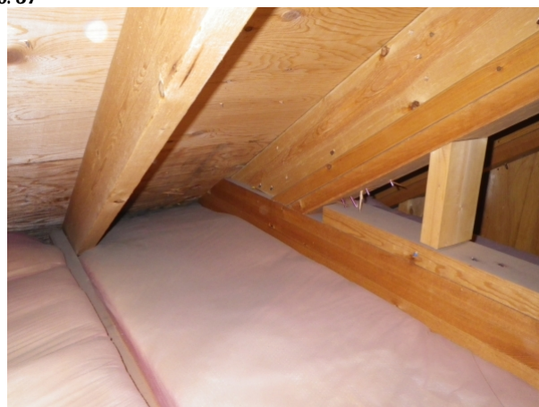
小屋裏＞梁、小屋組および野地板等
