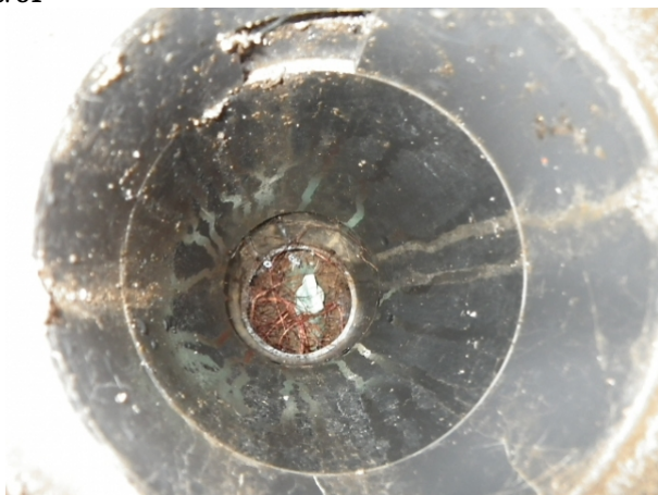
排水設備 > 最終枡（敷地内）
