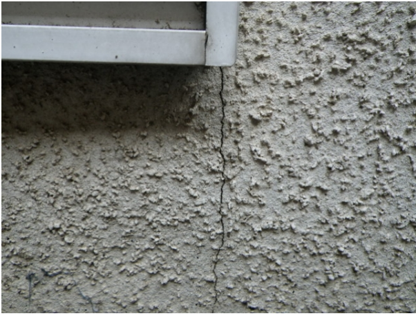
外壁仕上げ＞外装材表面＞モルタル塗り仕上げ等
