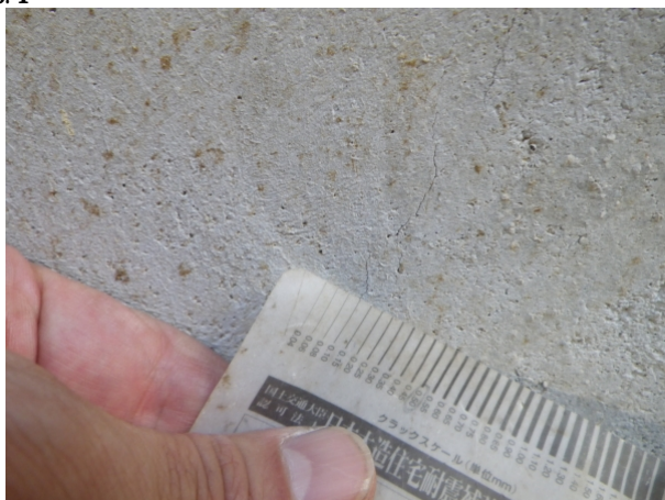
基礎 > 基礎表面 > モルタル仕上げ
