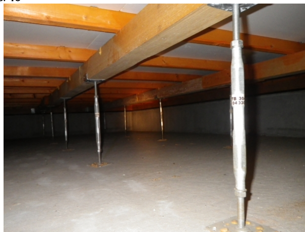
土台および床組 > 束 > 鋼製又は樹脂製
