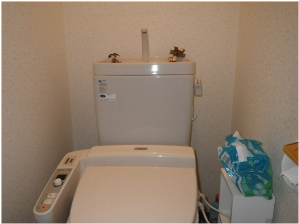
排水設備 > 排水管（建物内）
