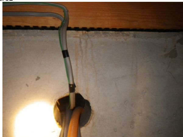
基礎および床下面 > 基礎 > 基礎立上り
