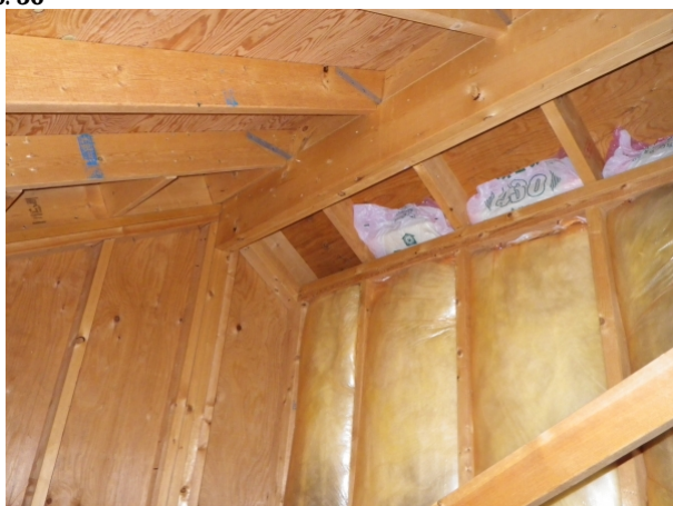
小屋裏＞梁、小屋組および野地板等
