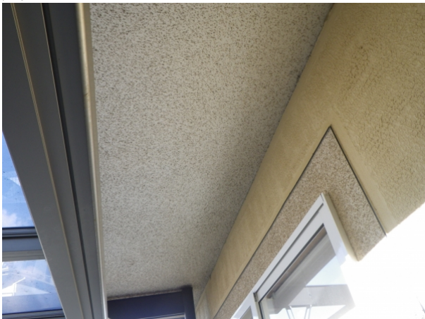
軒裏＞仕上材表面＞ケイカル板、合板等
