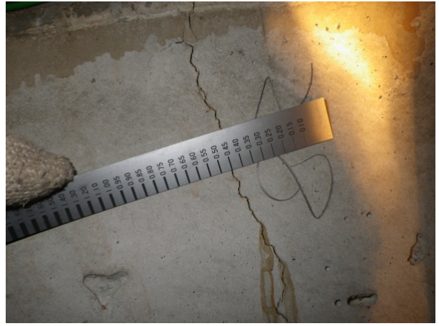
基礎および床下面 > 基礎 > 基礎立上り
