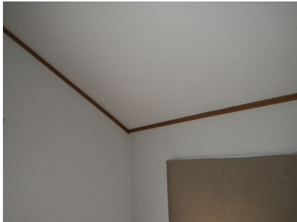
天井 ＞ 仕上材表面 ＞ 壁紙等
