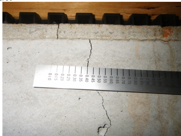
基礎および床下面 > 基礎 > 基礎立上り
