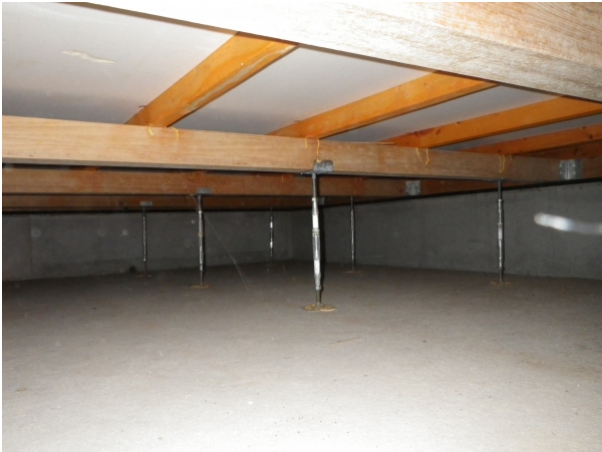
基礎および床下面 > 床下面 > 耐圧盤
