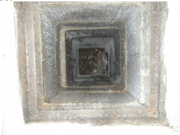
排水設備 > 最終枡（敷地内）
