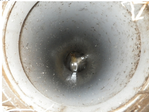
排水設備 > 最終拵（敷地内）
