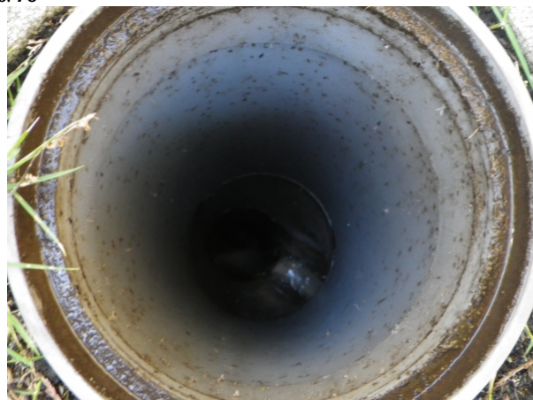
排水設備 > 最終拵（敷地内）
