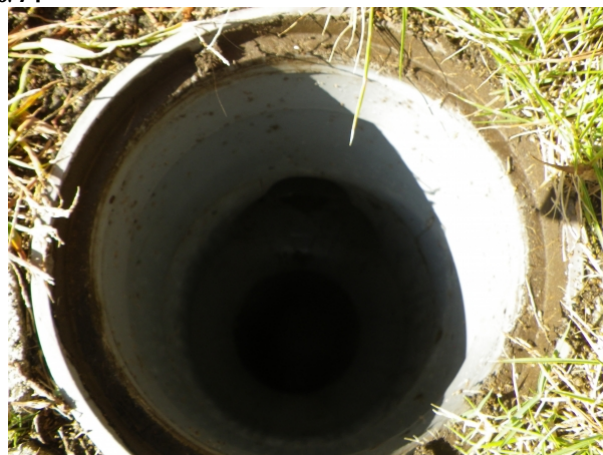
排水設備 > 最終拵（敷地内）
