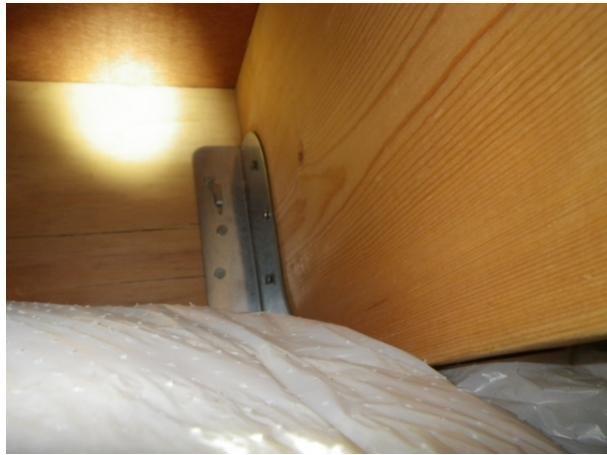
各階間の天井裏・下屋の小屋裏 > 接合部
