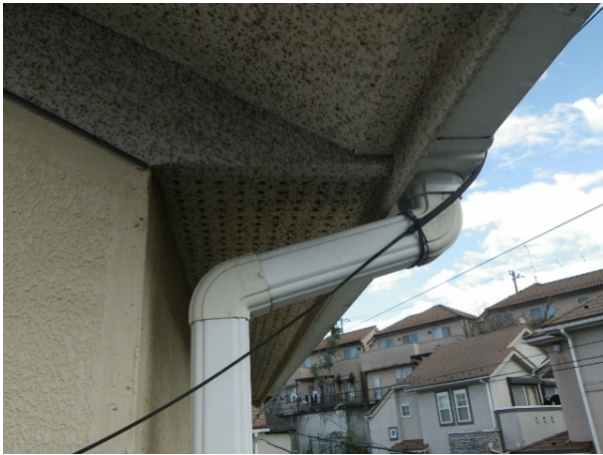
軒裏＞仕上材表面＞ケイカル板、合板等
