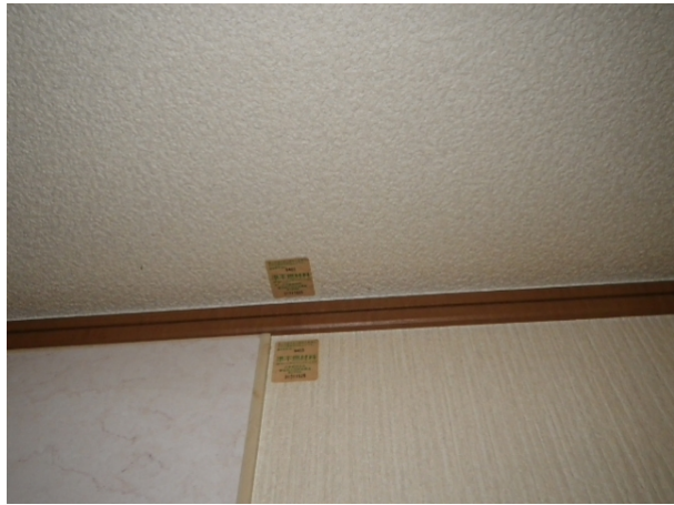
壁、柱および梁のうち屋内に面する部分 ＞ 仕上げ材表面 ＞ 壁紙等
