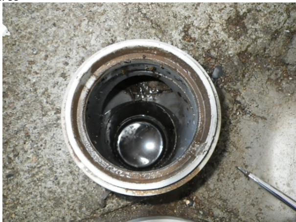
排水設備 > 最終枡（敷地内）
