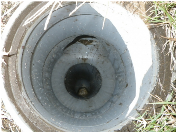
排水設備 > 最終拵（敷地内）
