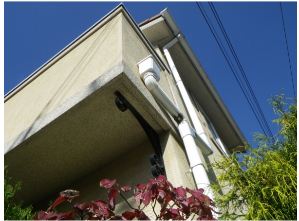
軒裏＞仕上材表面＞ケイカル板、合板等
