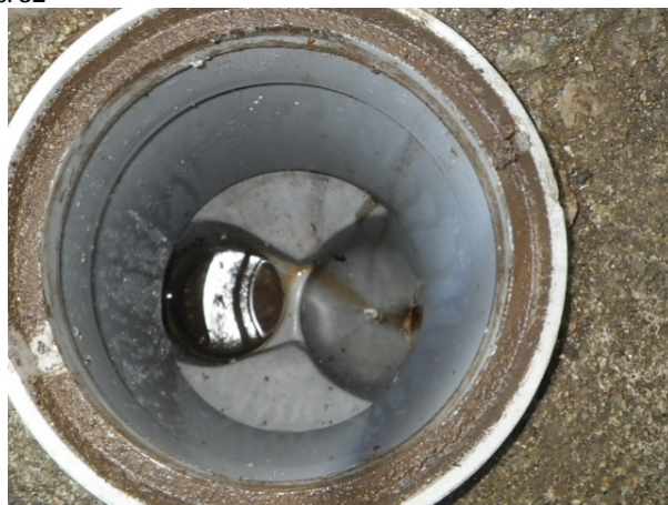
排水設備 > 最終枡（敷地内）
