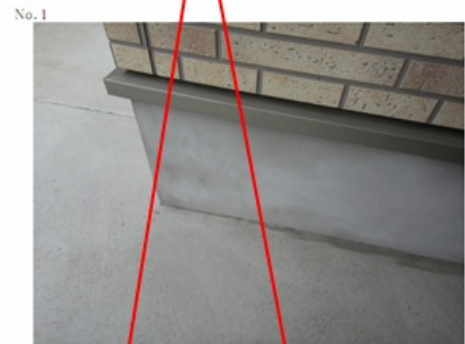
基礎 > 基礎表面 > モルタル仕上げ 基礎表面の仕上がり状態は、一部に表面仕上げモルタルの浮きが見られたものの、ひび割れ等は見られず、全体的には良好でした。
