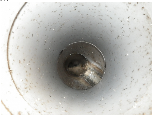
排水設備 > 最終枡（敷地内）
